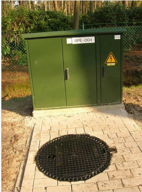
Figuur 17: Verharding ter hoogte van de centrale voedingskast (Bron: Grontmij)
