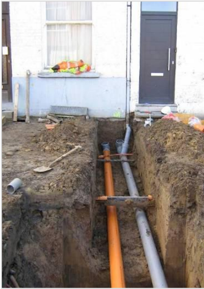
Figuur 16: Aanleg van een gescheiden huisaansluiting (Bron: Grontmij)
